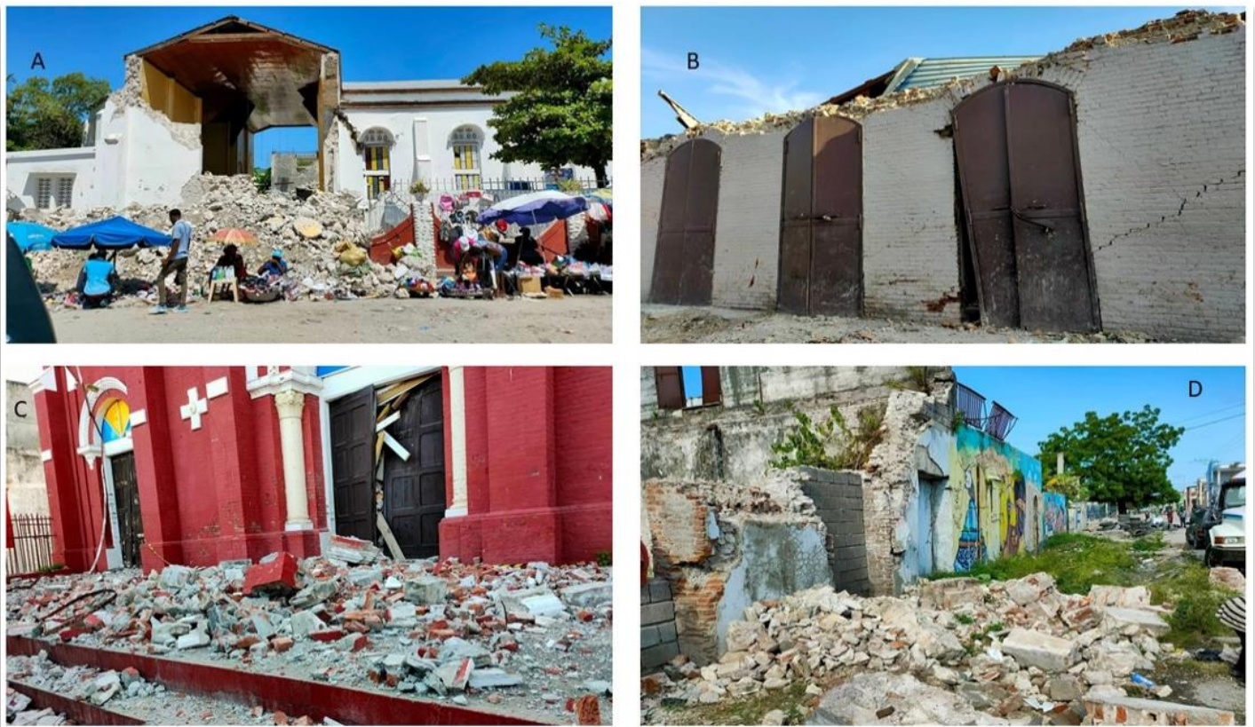
Figure 1 : Églises et anciennes maisons affectées par le séisme. A et B : Cayes ; C et D : Jérémie
